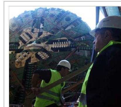
Muntatge de la tuneladora del TAV. Foto: ORIOL DURAN.
