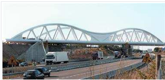
Viaducte de la línia de l'AVE al seu pas sobre l'AP-7 al terme de Riudellots de la Selva, ahir a la tarda.
