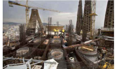
Mientras se espera el inicio de los trabajos del AVE, las obras de construcción de la Sagrada Família siguen su curso / LVE / ROSER VILALLONGA
